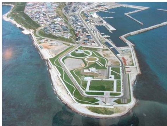
津波被害直後の青苗地区と現在
